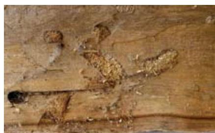
Foto 2. Siklaste kahjustused puidus. Suured ovaalsed käigud on täidetud näripuruga.
