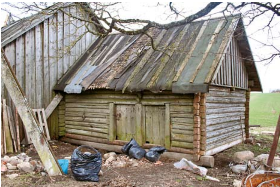
Pritsu ait pärast seinte restaureerimist. Alumised palgid on vahetatud, hoone on tõstetud maapinnast kõrgemale.
